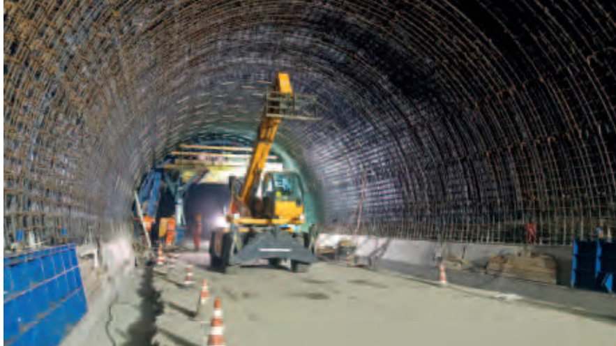
■ STAGE 5. Posa armatura a traliccio nei tratti di imbocco di Colle destra
