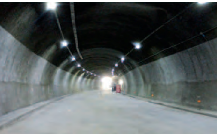
■ Piano di rinnovo strutturale dei rivestimenti. Sezione tipo C1 – Calcestruzzo proiettato e Sezione tipo D
