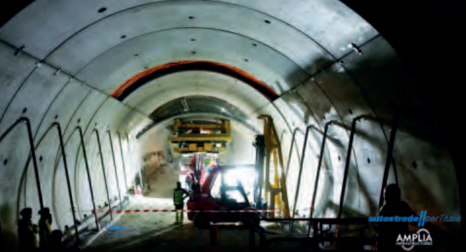
■ Piano di rinnovo strutturale dei rivestimenti. Sezione tipo B – Rivestimento con lastre prefabbricate + getto in opera
