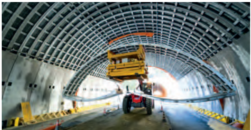
■ Piano di rinnovo strutturale dei rivestimenti. Sezione tipo C1 – Calcestruzzo proiettato e Sezione tipo D
