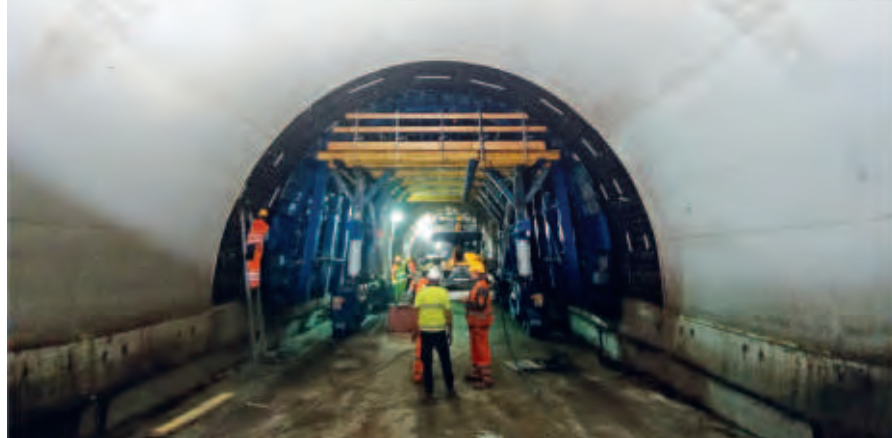
■ STAGE 5 e 6. Getto cls in opera mediante cassero metallico
